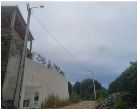
TRAVESSA DO MACIEIRO AMPLIAÇÃO DE REDE ELÉTRICA
