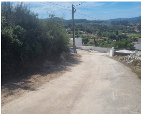
RUA DAS COUTADAS: AMPLIAÇÃO DE REDE DE ABASTECIMENTO DE ÁGUA
