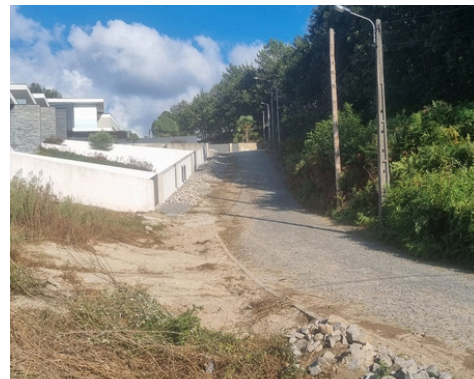
RUA DO FOLGOSO: AMPLIAÇÃO DE REDE DE ABASTECIMENTO DE ÁGUA
