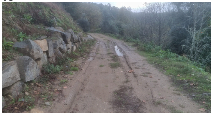
ALARGAMENTO DO CAMINHO FLORESTAL - TRAVESSA DA PANDA
